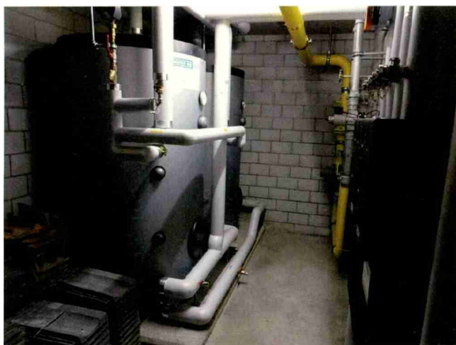
Die beiden 600-l-Boiler und rechts die Modulverteiler-Elemente von Weishaupt in einer der Unterstationen.
